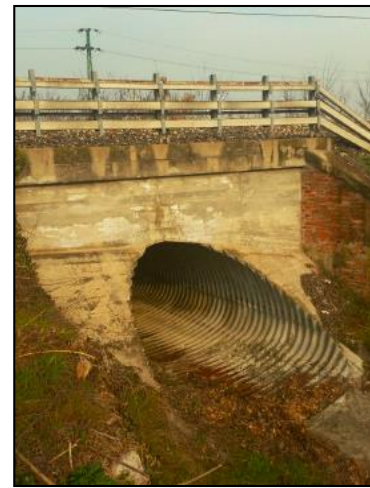
Ponticello consolidato in calcestruzzo armato
