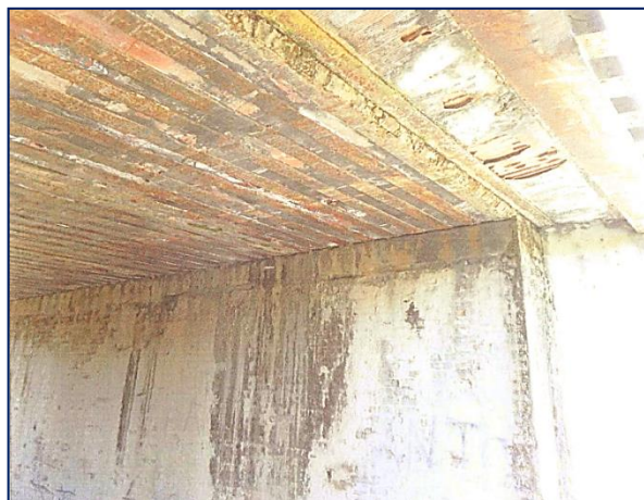
Intradosso delle travi ad impalcato
