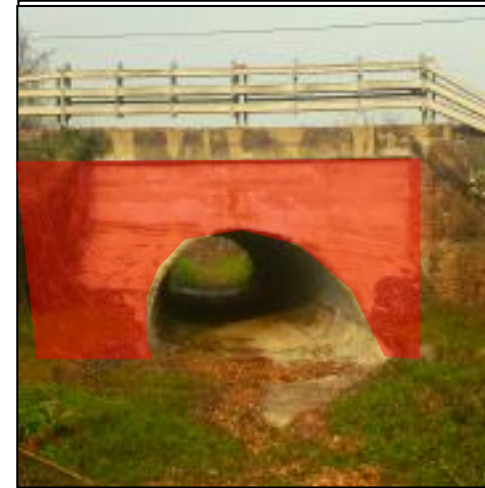
Ponticello consolidato in calcestruzzo armato
